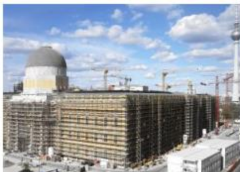
Technisches Monitoring der Gebäudetechnik des Berliner Schloss
