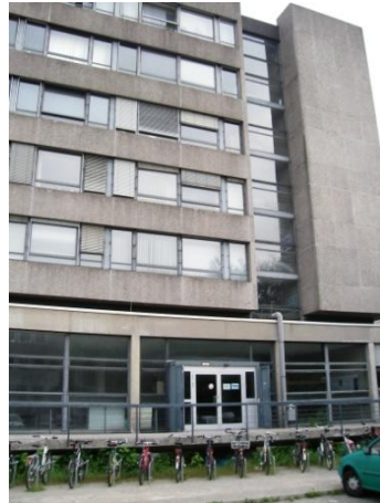
Gebäude der TU Braunschweig, 60er Jahre
