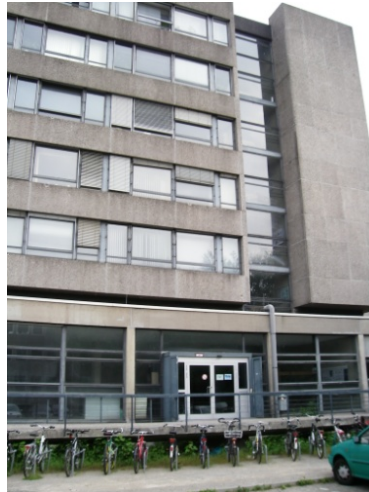
Gebäude der TU Braunschweig, 60er Jahre
