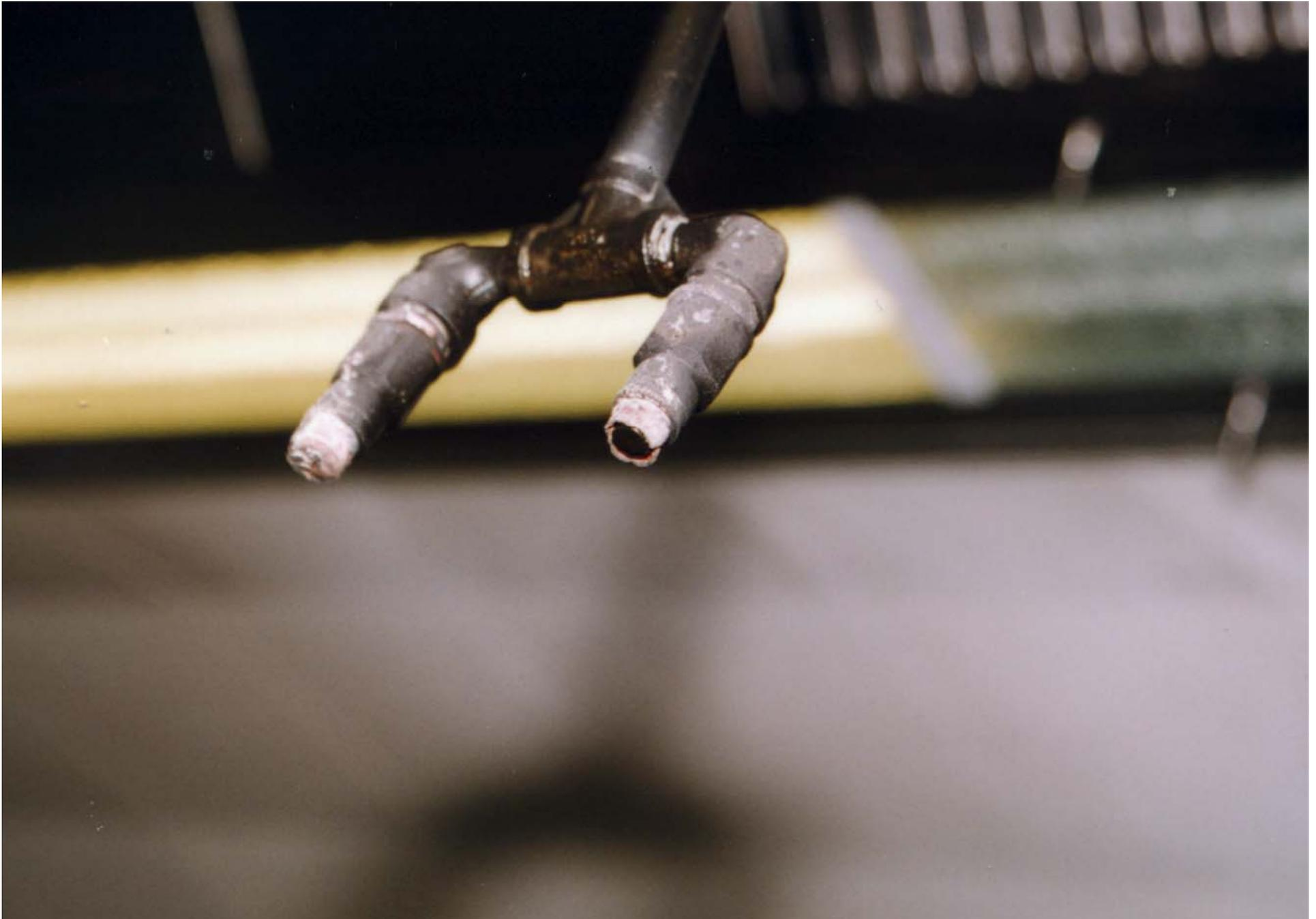
**Kein Schmelzlot: -Löschanlage nicht vorgespannt-**
