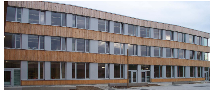
Passivhauptschule Frankfurt Preungesheim
