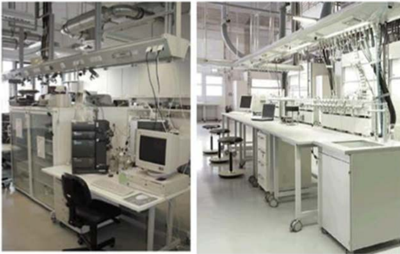
Beispiele für Deckenversorgungssysteme Typ MZ 2:
