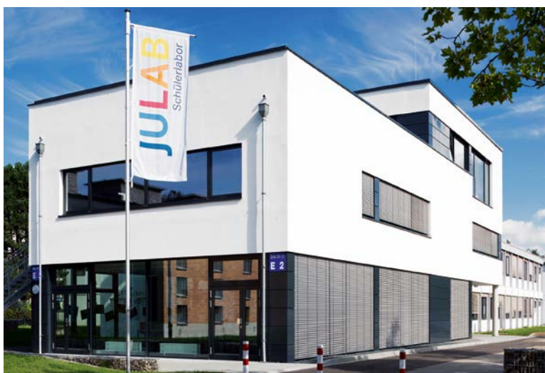
Außenansicht vom Neubau des Schülerlabors JuLab
